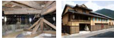
奈落到設置された廻り舞台装置
